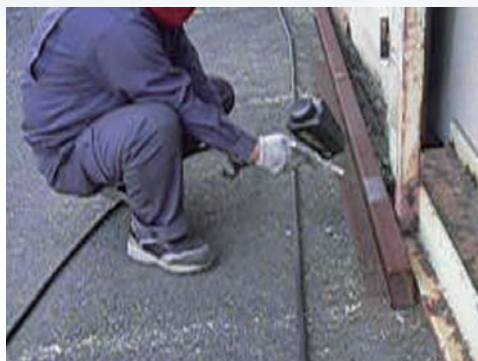
塗膜剥がし・錆取り例
